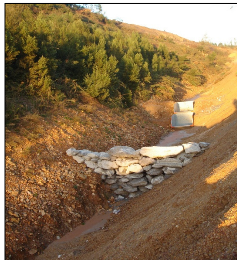
Fig. 2 – “Cordão de Terras” e Bacia de Decantação implementados junto ao Pk inicial da zona de intervenção das cinzas (02-11-10)
