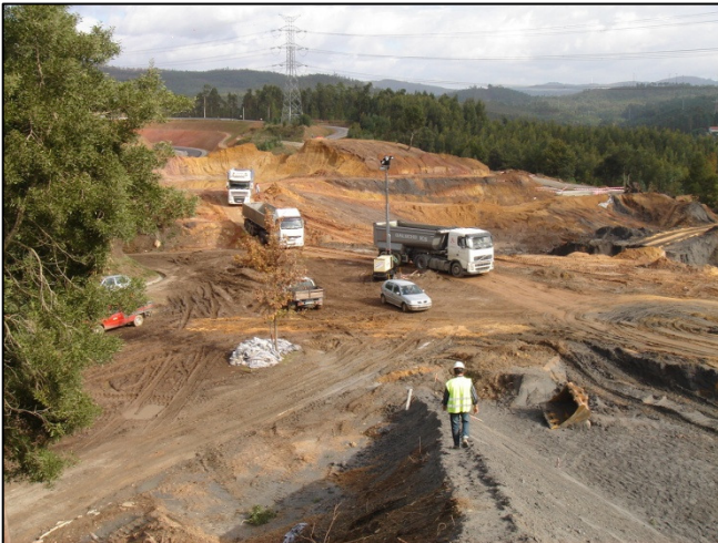
Fig. 11 – Vista geral de área já intervencionada (10-11-10)
