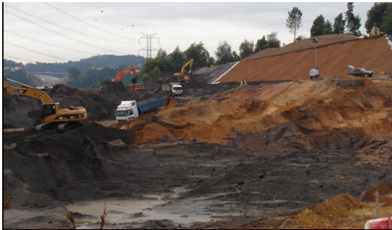
Fig. 19 – Continuação dos trabalhos de escavação e transportes das cinzas e estabilização/protecção de taludes – suspensão do transporte das cinzas para aterro de resíduos não perigosos no final do dia (16-11-10)
