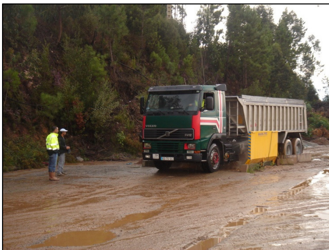
Fig. 23 – Lavagem dos rodados à saída da obra
