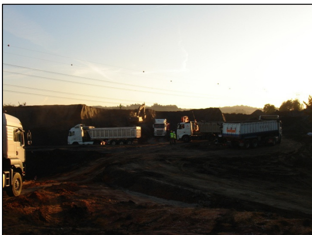
Fig. 1 – Continuação dos trabalhos de escavação e transportes das cinzas (02-11-10)
