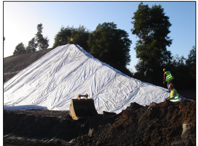
Fig. 12 – Cobertura de talude definitivo com geotêxtil, no âmbito dos trabalhos de estabilização / protecção dos taludes (10-11-10)
