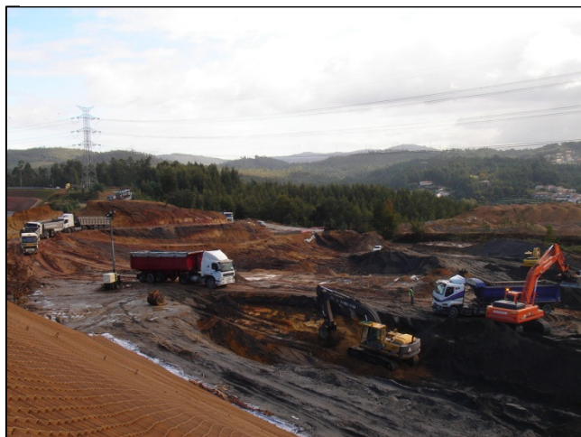
Fig. 16 – Continuação dos trabalhos de escavação e transportes das cinzas (12-11-10)
