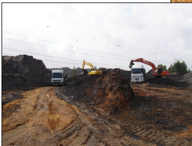
Fig. 7 – “Cordão de Terras” e Bacia de Decantação implementados junto ao Pk inicial da zona de intervenção das cinzas (09-11-10)
